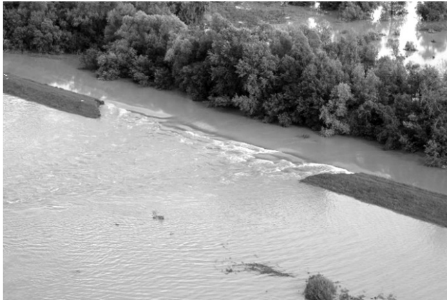
Slika 1. Puknuće nasipa u Račinovcima
